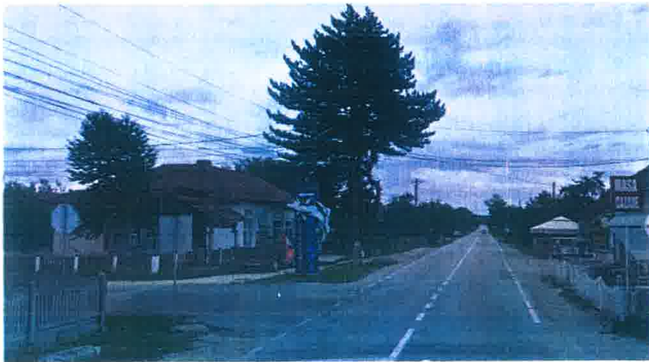
Intersecție– DN 67D cu DJ672C - iluminat lateral, nivel iluminare 53lx
