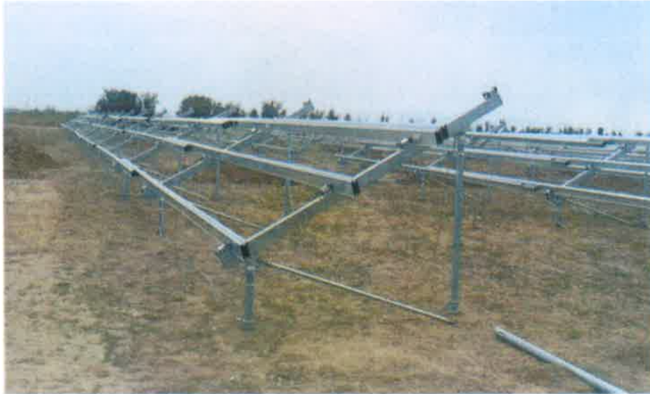
Figura 5 : Sistem de cadru mono-rail aluminiu cu piloti insurubati– dedicat sistemelor fotovoltaice terestre. Sursa: Krinner Solar
